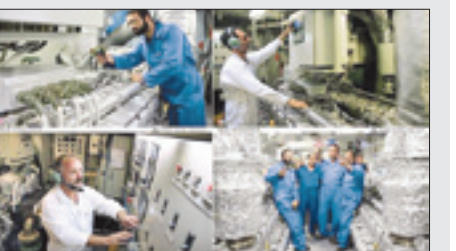
بخشی از تجهیزات موتورخانه شناور درفش، سومین محصول پروژه سینا که در سال ۱۳۹۱ به ناوگان شمال تحویل داده شد
